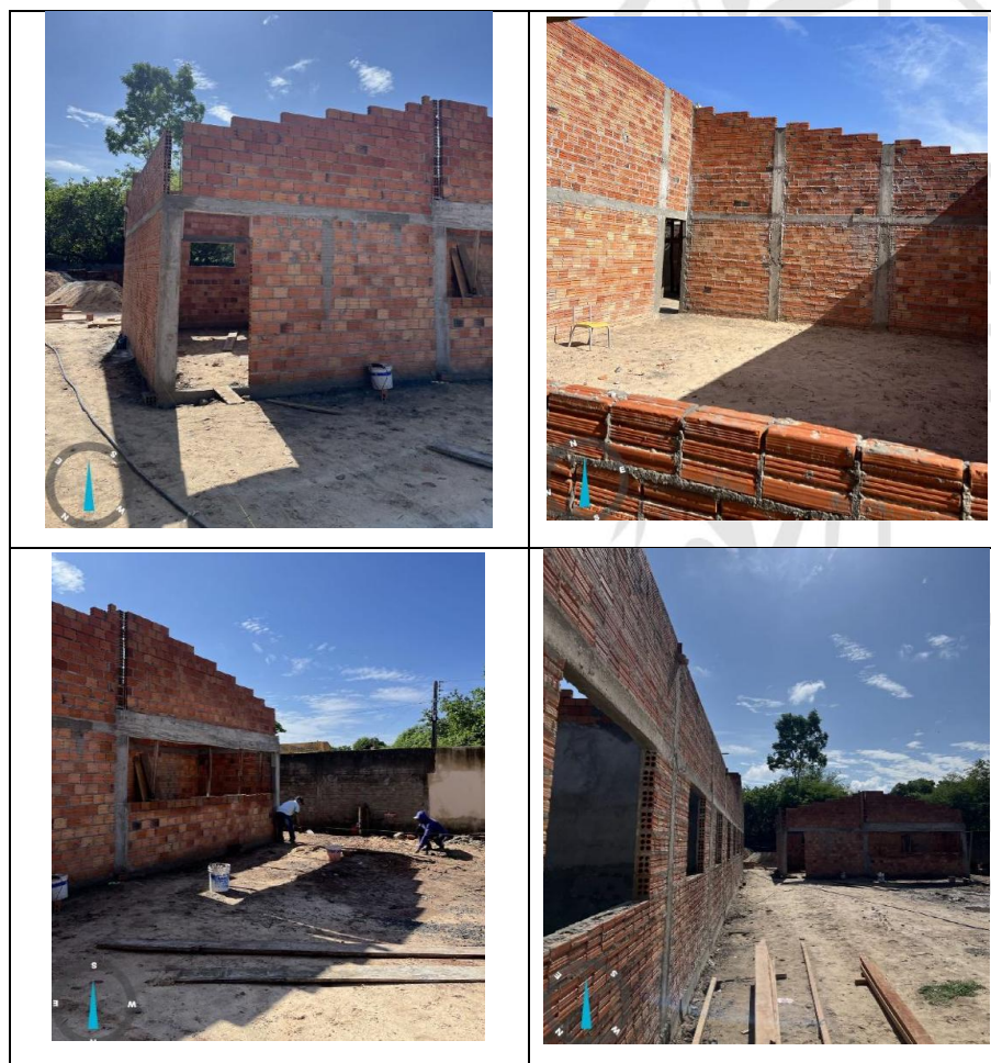
Figura 22 - Reforma e Ampliação da Escola Luiz de Brito Mello
