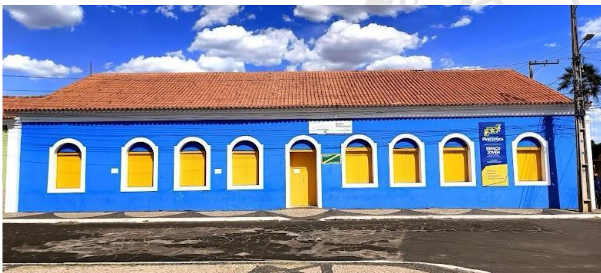
Figura 19 - Registro Fotográfico da Reforma
