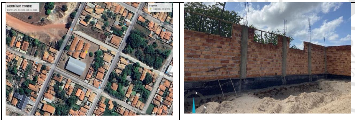
Figura 25 - Reforma e Ampliação da Escola Hermínio Conde
