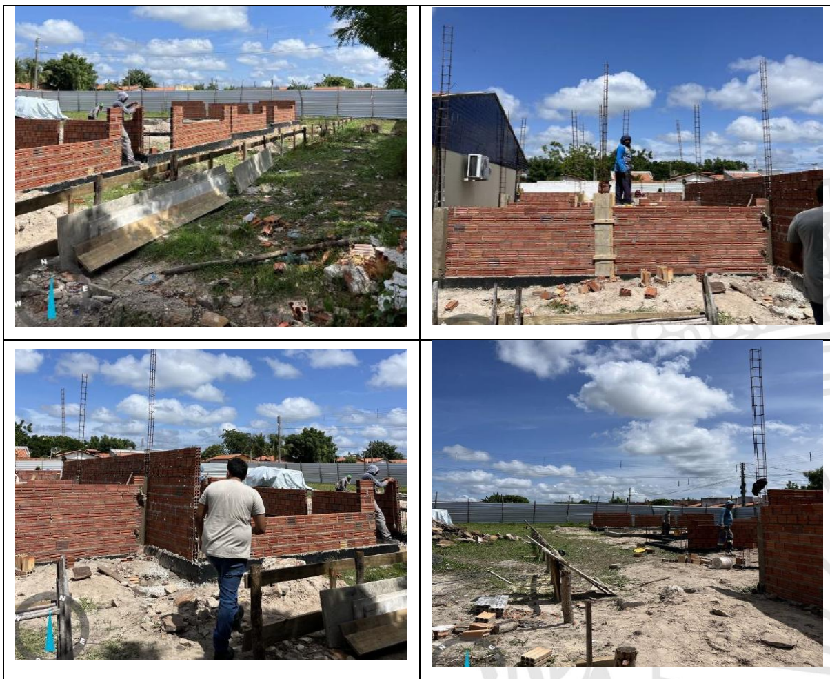
Figura 24 - Reforma e Ampliação da Creche Débora Alencar
