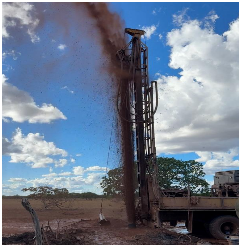
Figura 131 - Perfuração de poço tubular da localidade chapada da Torre na zona rural no município de São José do Piauí - PI
