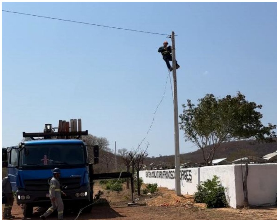
Figura 133 – Serviço de manutenção de Iluminação pública: Instalação de postes e rede elétrica de iluminação pública no Cemitério Francisco Borges na zona urbana do município.
