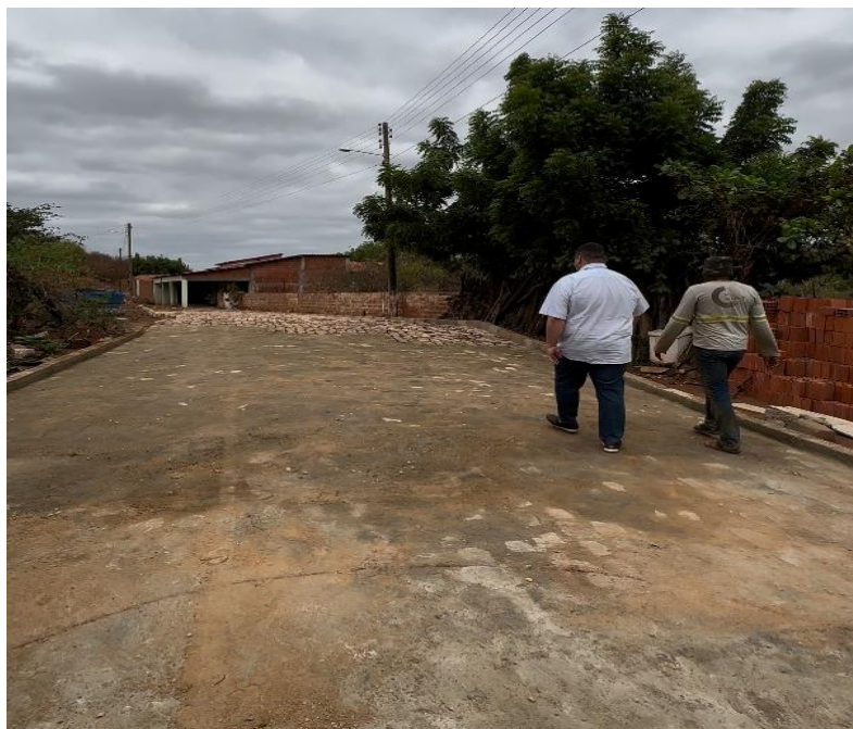
Figura 125 - Realização de Pavimentação Poliédrica (Calçamento) no Povoado Saco da Várzea
