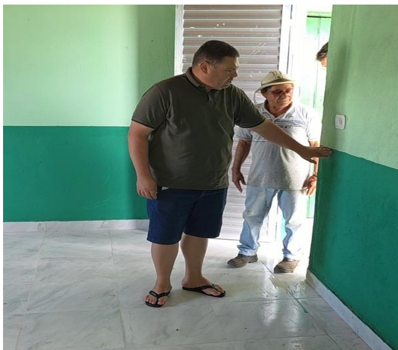
Figura 132 - Reforma da escola Nossa Senhora de Fatima no povoado Oco D'água
