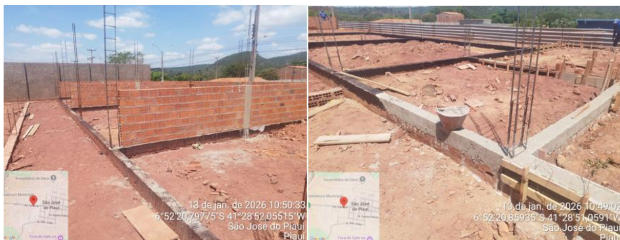
Figura 136 - Início da Construção da Unidade Escolar Municipal Severo Eulálio na sede do município.
