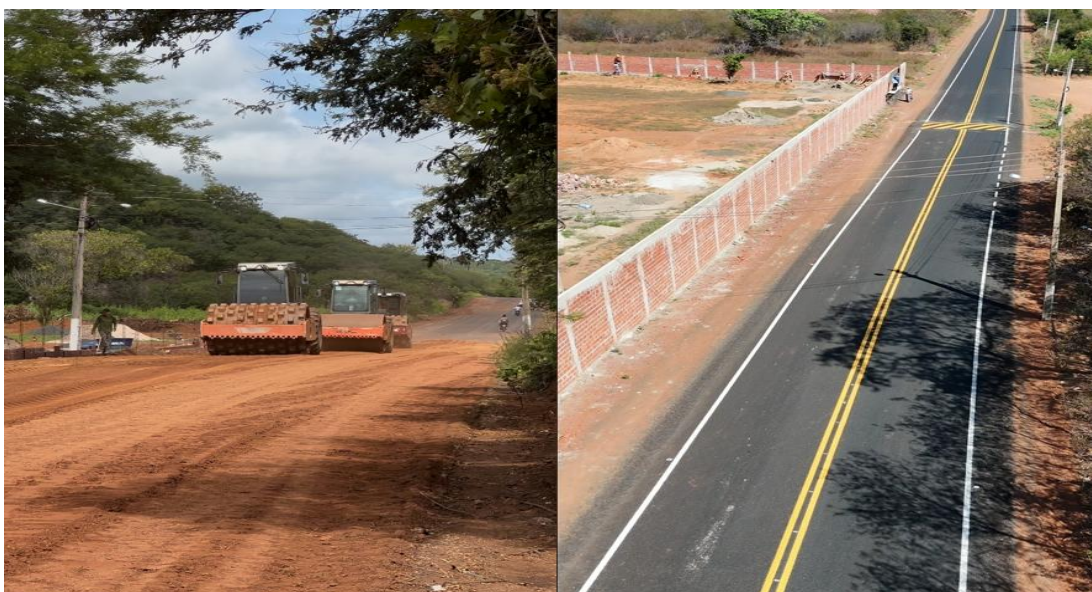
Figura 124 - Recuperação da Rodovia Zezim Bezerra que liga São José do Piauí ao Povoado Atalho, em parceria com o governo do Estado do Piauí
