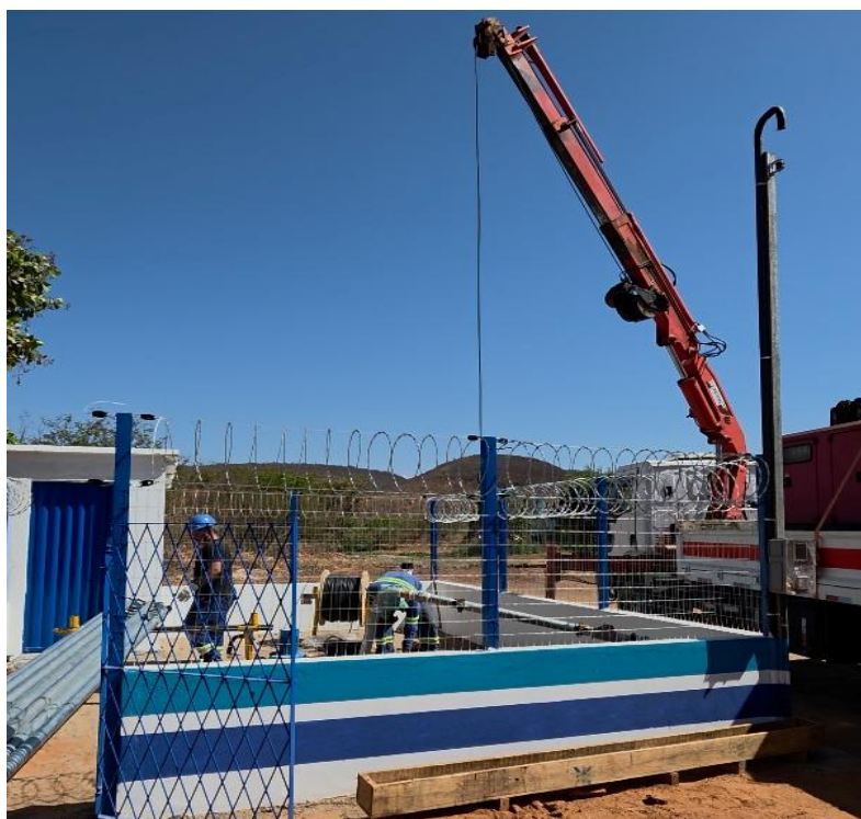
Figura 126 - Doação de terreno para a águas do Piauí para perfuração do Poço tubular na sede para abastecimento
