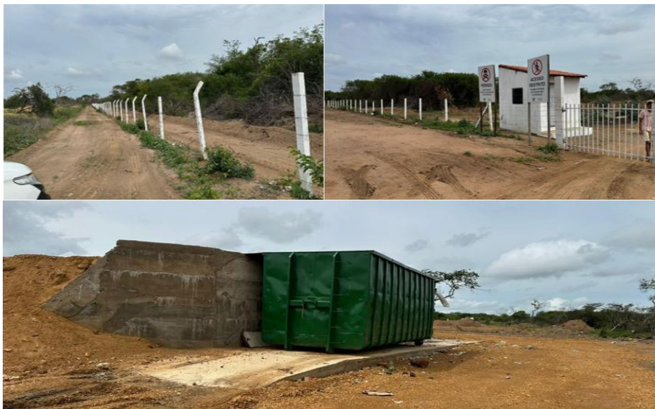
Figura 107 – Cercamento, placas de sinalização e vigilância e Estrutura de transbordo
