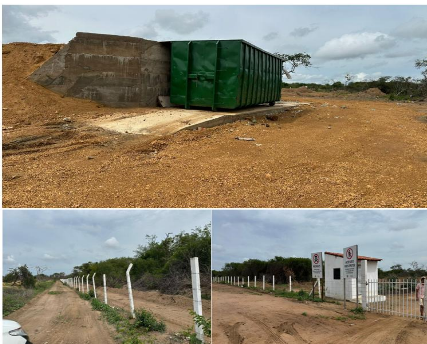
Figura 134 - Reforma da estrutura física do lixão (instalação de Estrutura de transbordo, Cercamento, placas de sinalização e vigilância)
