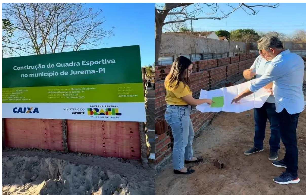
Imagem 42 - Construção de quadra esportiva
