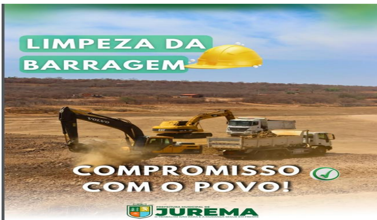
Imagem 33 - Limpeza de barragem
