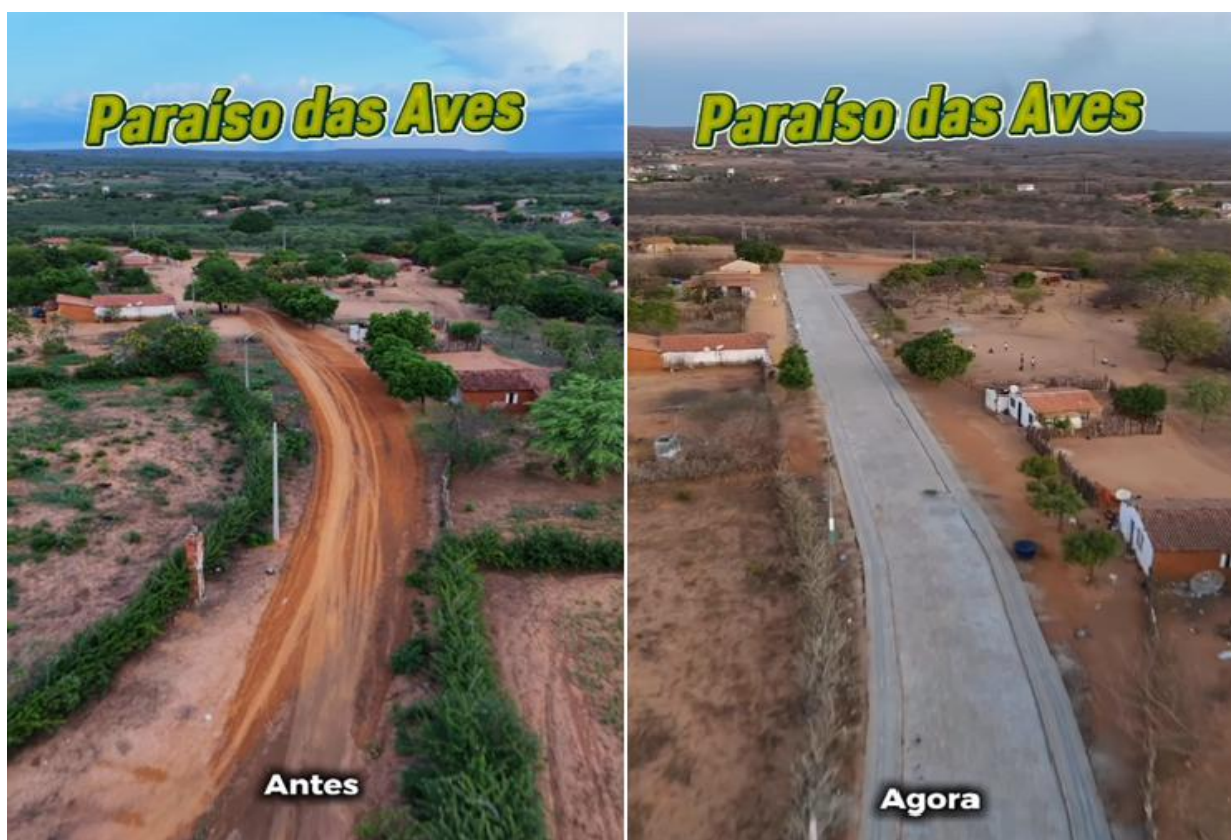
Imagem 39 - Pavimentação de ruas na localidade Paraíso das Aves
