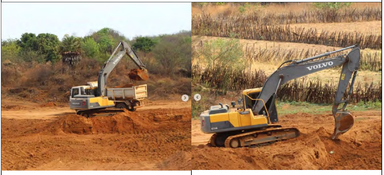
Reforma e ampliação da barragem do povoado Ponta da Serra
