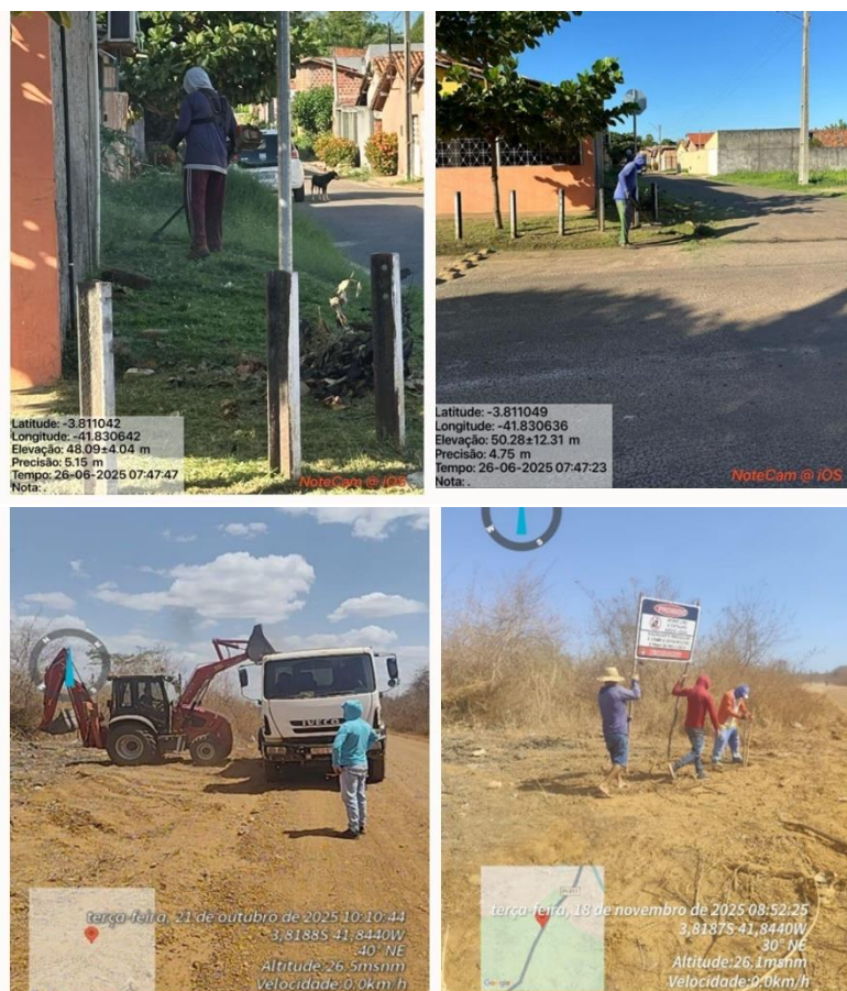
Figura 78 - Ações contínuas de limpeza urbana e manutenção de vias: serviços de roçagem, remoção de resíduos em estradas vicinais e instalação de sinalização educativa.
