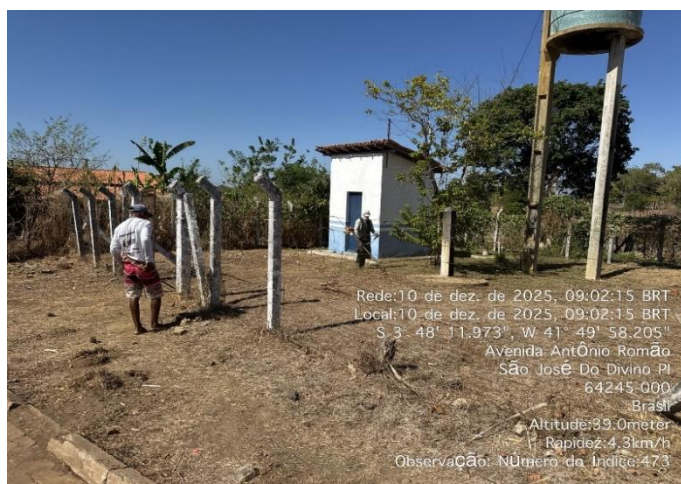
Figura 77 - Serviços de manutenção e limpeza de poço tubular no bairro Triunfo.
