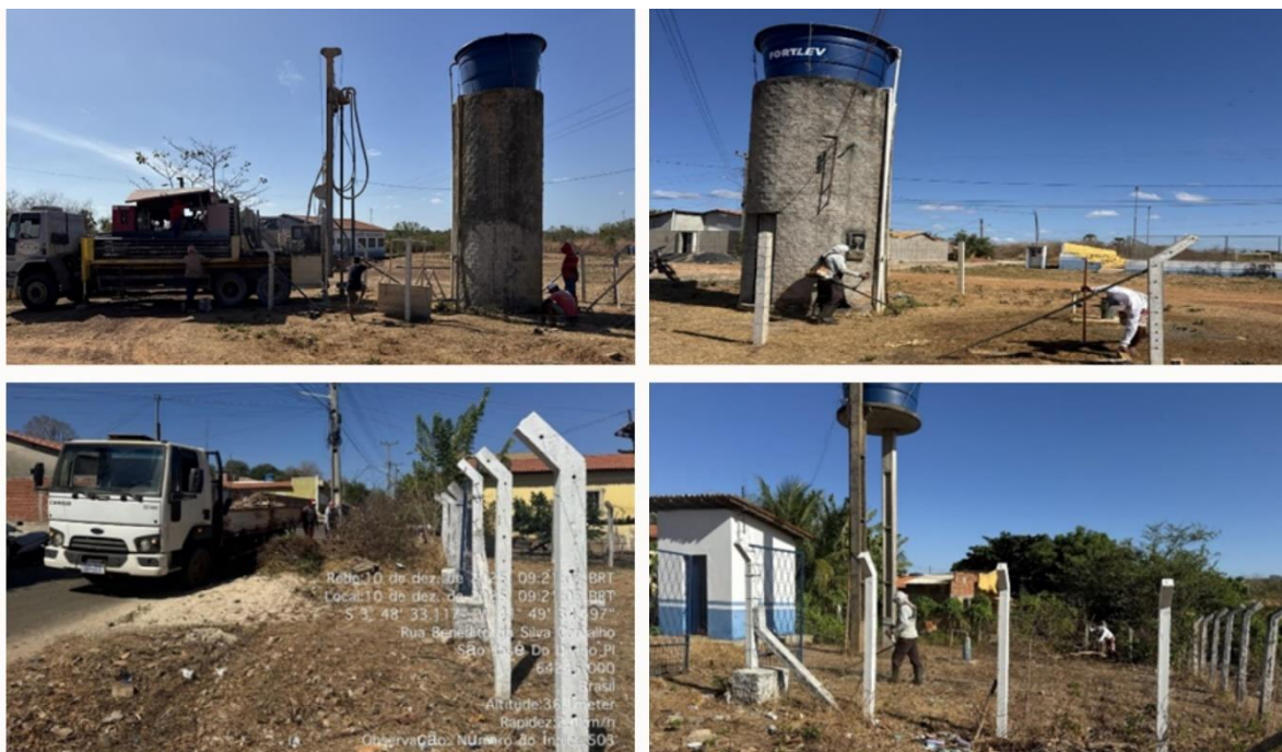
Figura 76 - Serviços de aprofundamento e limpeza de poço tubular no bairro Matadouro e Batoque.
