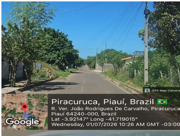
Foto 63 – Rua Vereador João Rodrigues de Carvalho com pavimento, margens vegetadas e calçadas descontínuas, sem bocas de lobo aparentes. Coordenadas: -3.921470, -41.719015.
