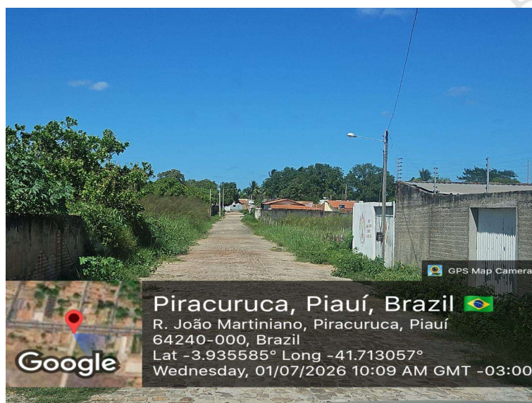
Foto 24 – Rua João Martins sem pavimentação, com vegetação nas margens, superfície irregular e ausência de estruturas de drenagem. Coordenadas: -3.935585, -41.713057.
