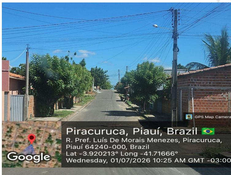
Foto 64 – Rua Prefeito Luís de Moraes Menezes com pavimento em pedras, ocupação residencial e inexistência aparente de captação pluvial. Coordenadas: -3.920213, -41.716660.
