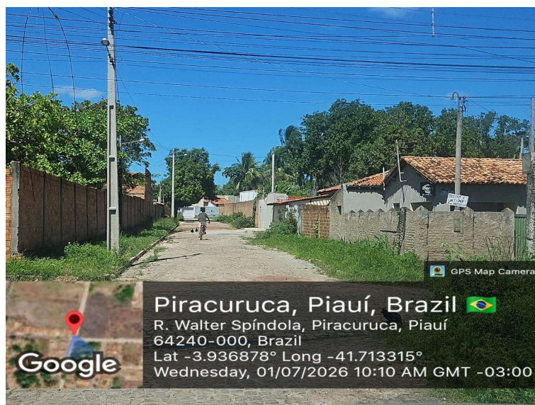
Foto 29 – Trecho não pavimentado da Rua Walter Spíndola, com ocupação residencial, irregularidade do leito e ausência de microdrenagem. Coordenadas: -3.936878, -41.713315. Fonte: Acervo técnico da RN Engenharia, levantamento de campo georreferenciado realizado em julho de 2026.
