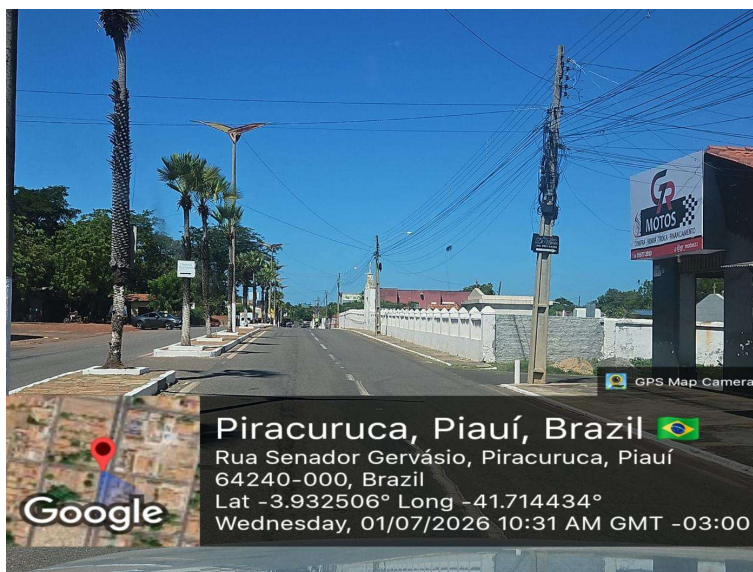
Foto 73 – Rua Senador Gervásio em corredor comercial, com pavimento, calçadas e drenagem superficial junto ao bordo. Coordenadas: -3.932506, -41.714434.
