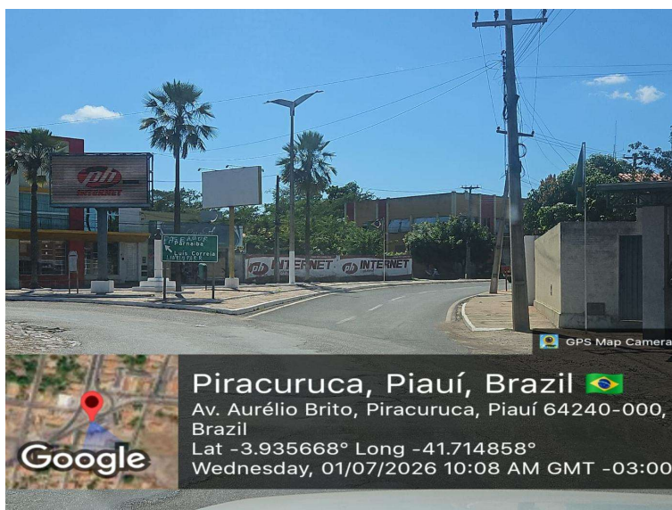
Foto 19 – Interseção pavimentada da Avenida Aurélio Brito, com meio-fio e áreas comerciais, onde o escoamento pluvial ocorre predominantemente pela superfície da via. Coordenadas: -3.935668, -41.714858.
