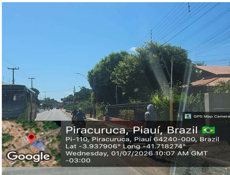
Foto 17 – Trecho da PI-110 com pista pavimentada, vegetação próxima às margens e drenagem dependente do escoamento superficial lateral. Coordenadas: -3.937906, -41.718274.
