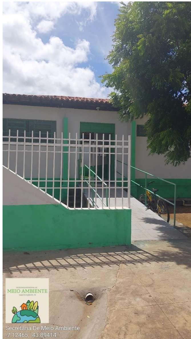
Figura 6: Reforma da UAB
