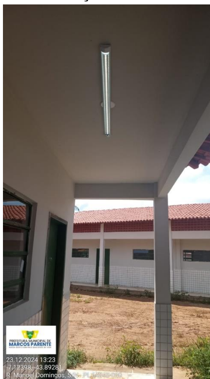
Figura 2: Limpeza da obra e manutenção da iluminação na Creche Tia MarluCIA
