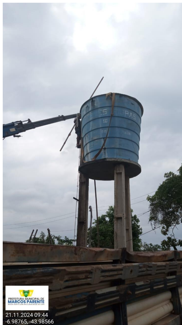
Figura 4: Manutenção da Caixa d'água na Vila Guimarães
