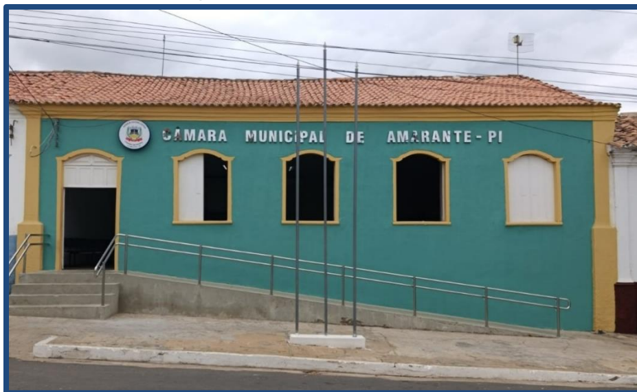
Figura 1 – Sede da Câmara Municipal
