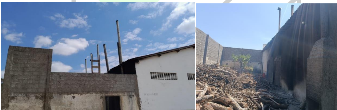
Foto 23 e 24: Visita e resultado da visita na COAMA. Causa da visita emissão de gases por causa da altura das chaminés, foi feita a visita no dia 19 de setembro 2025 e em novembro foram feita as modificações.
