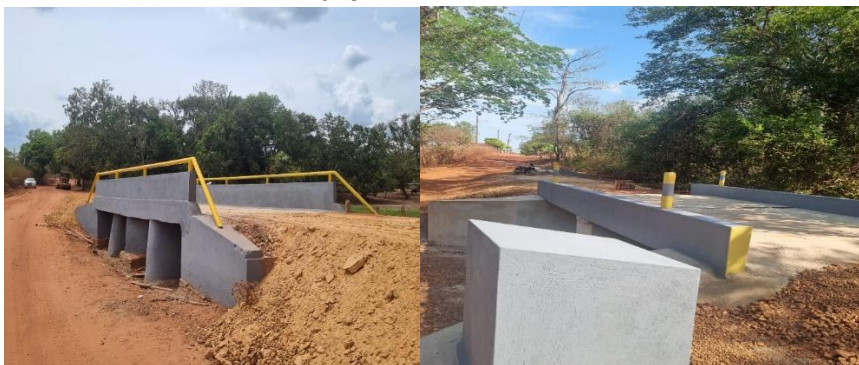
Foto 1. Construção de pontes em concreto armado. Foto 2. Reforma e ampliação das escolas municipais. Fonte: Secretaria Municipal de Obras e Serviço Público, 2025.
