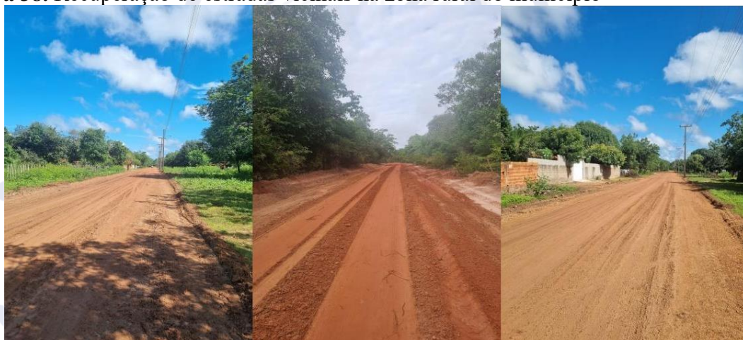
Figura 38. Recuperação de estradas vicinais na zona rural do município
