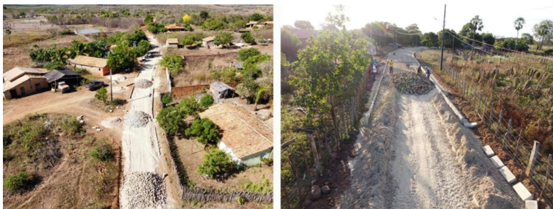
Figura 128 - Execução de pavimentação em paralelepípedo nas localidades Jucá e Tabocal.
