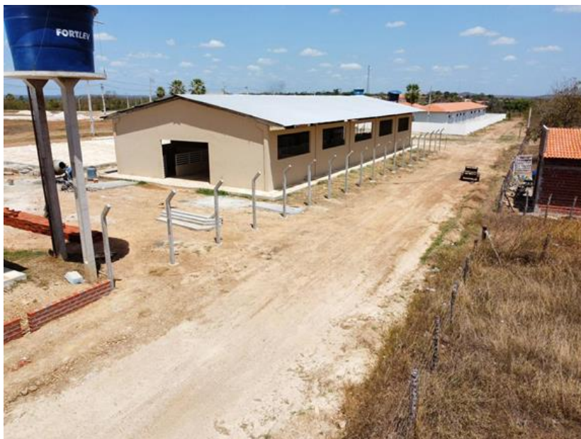
Figura 131 - Obras de construção do Parque de Exposição de Animais.
