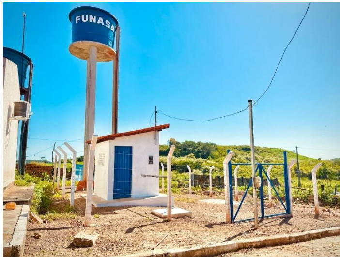
Figura 129 - Implantação do novo sistema de abastecimento de água na localidade Barroço.
