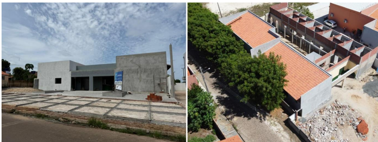
Figura 133 - Obra em fase de conclusão do centro administrativo para serviços socioassistenciais.
