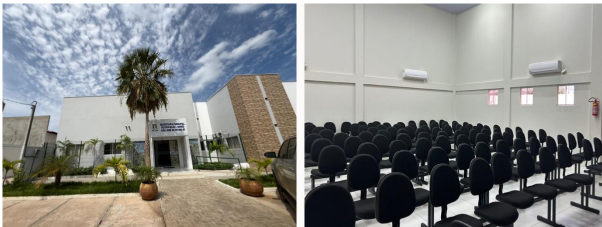
Figura 125 - Nova sede da Secretaria Municipal de Educação e Centro de Formação: ambiente estruturado para atividades pedagógicas.
