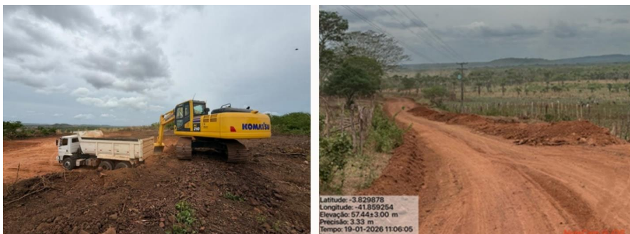
Figura 127 - Execução de serviços de recuperação e melhoria da trafegabilidade na estrada vicinal do Assentamento Carolina.
