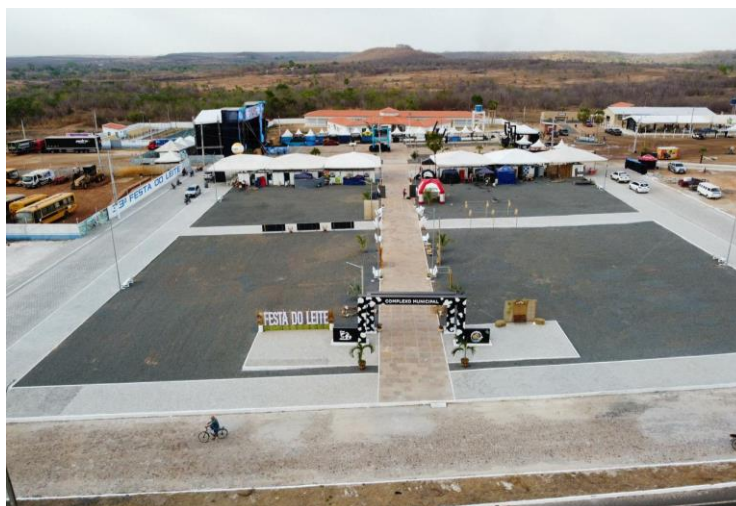
Figura 132 - Fase final de construção da Praça da Feirinha no Complexo da Festa do Leite.
