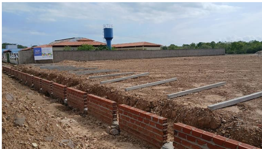
Figura 130 - Fase inicial da construção do campo de futebol na localidade Olaria.
