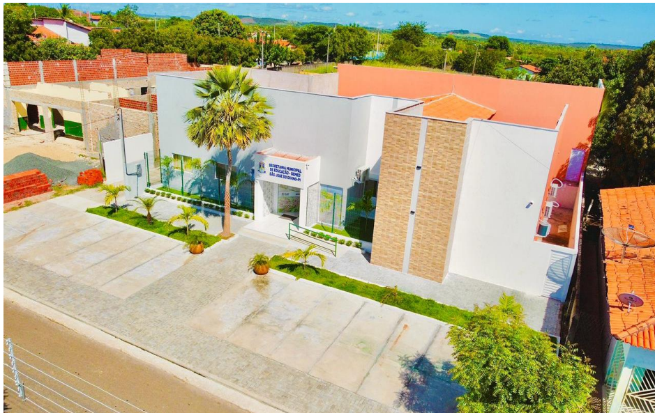
Figura 53 - Sede da Secretaria Municipal de Educação e Centro de Formação de Professores após conclusão da obra e inauguração.
