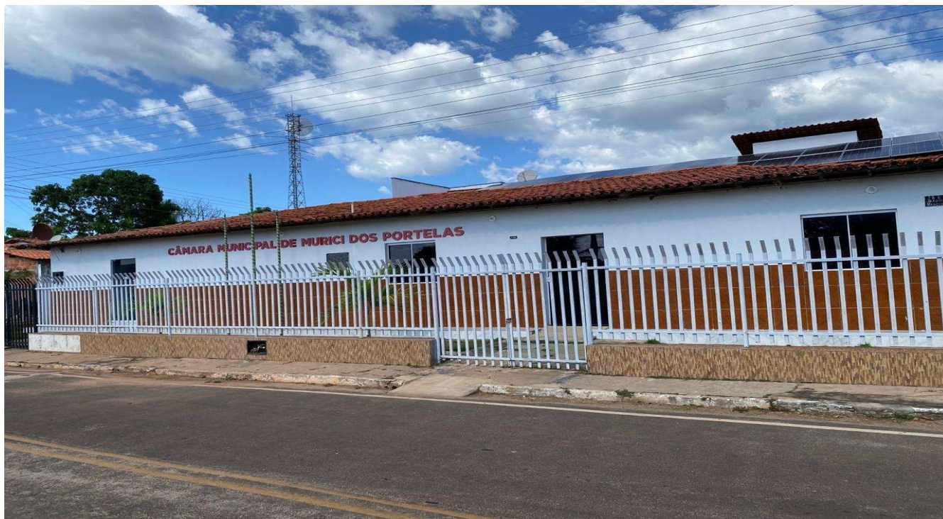
Figura 1 – Sede da Câmara Municipal
