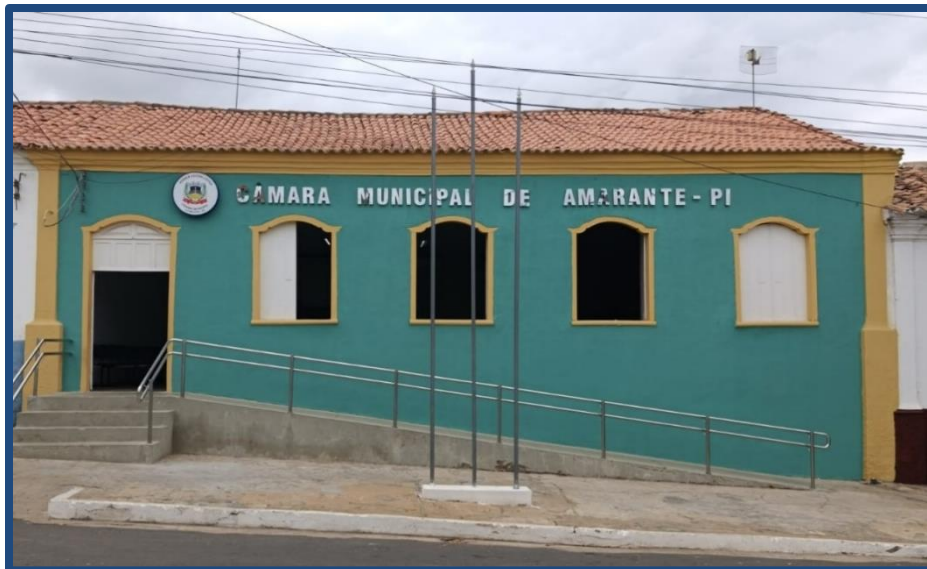
Figura 1 – Sede da Câmara Municipal
