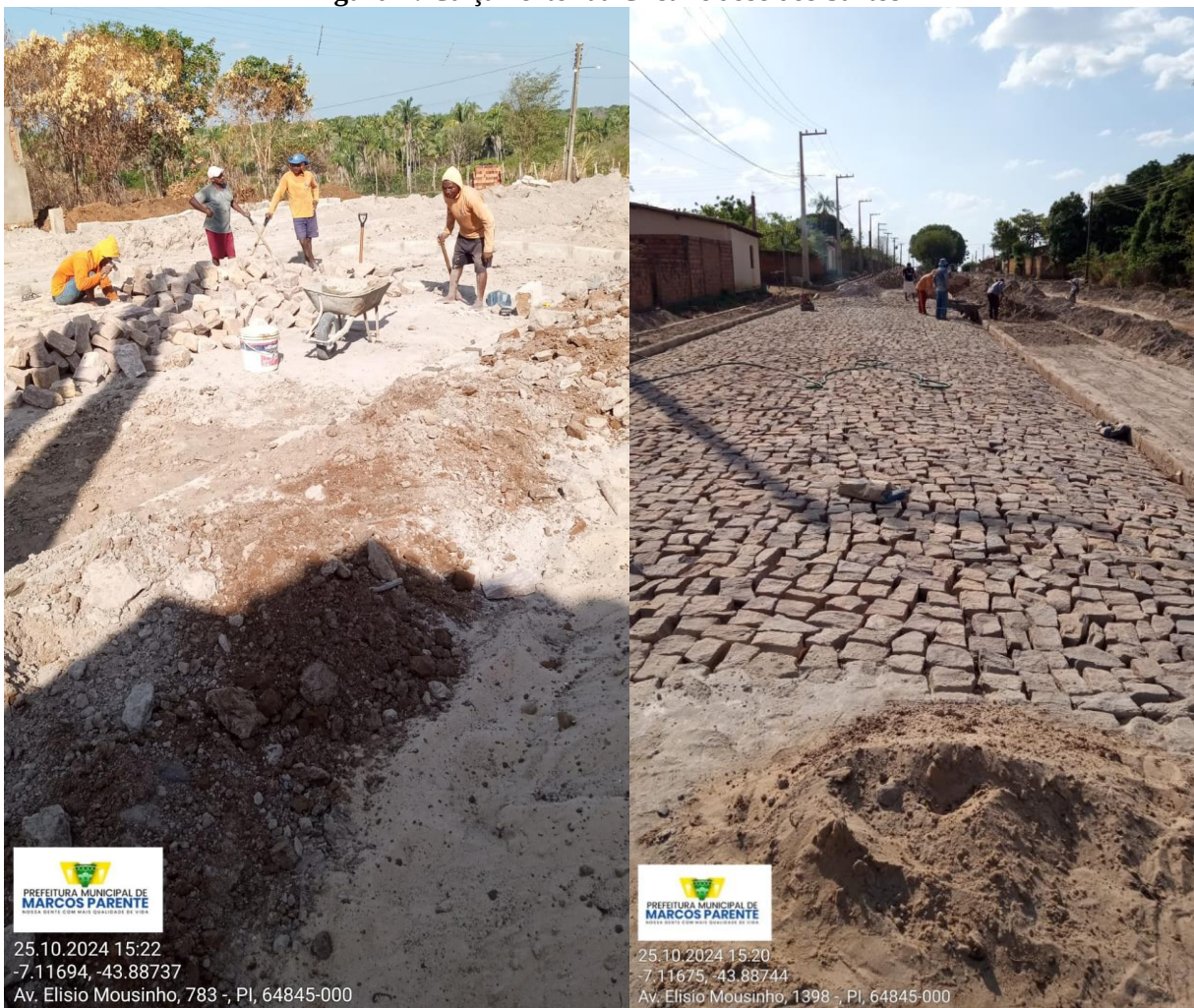
Figura 8: Calçamento Rua Emidio José de Oliveira
