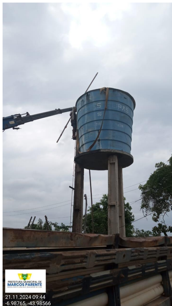
Figura 4: Manutenção da Caixa d'água na Vila Guimarães
