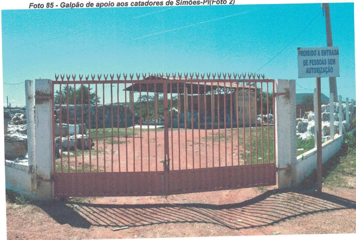
Foto 85 - Galpão de apoio aos catadores de Simões-PI(Foto 2)
