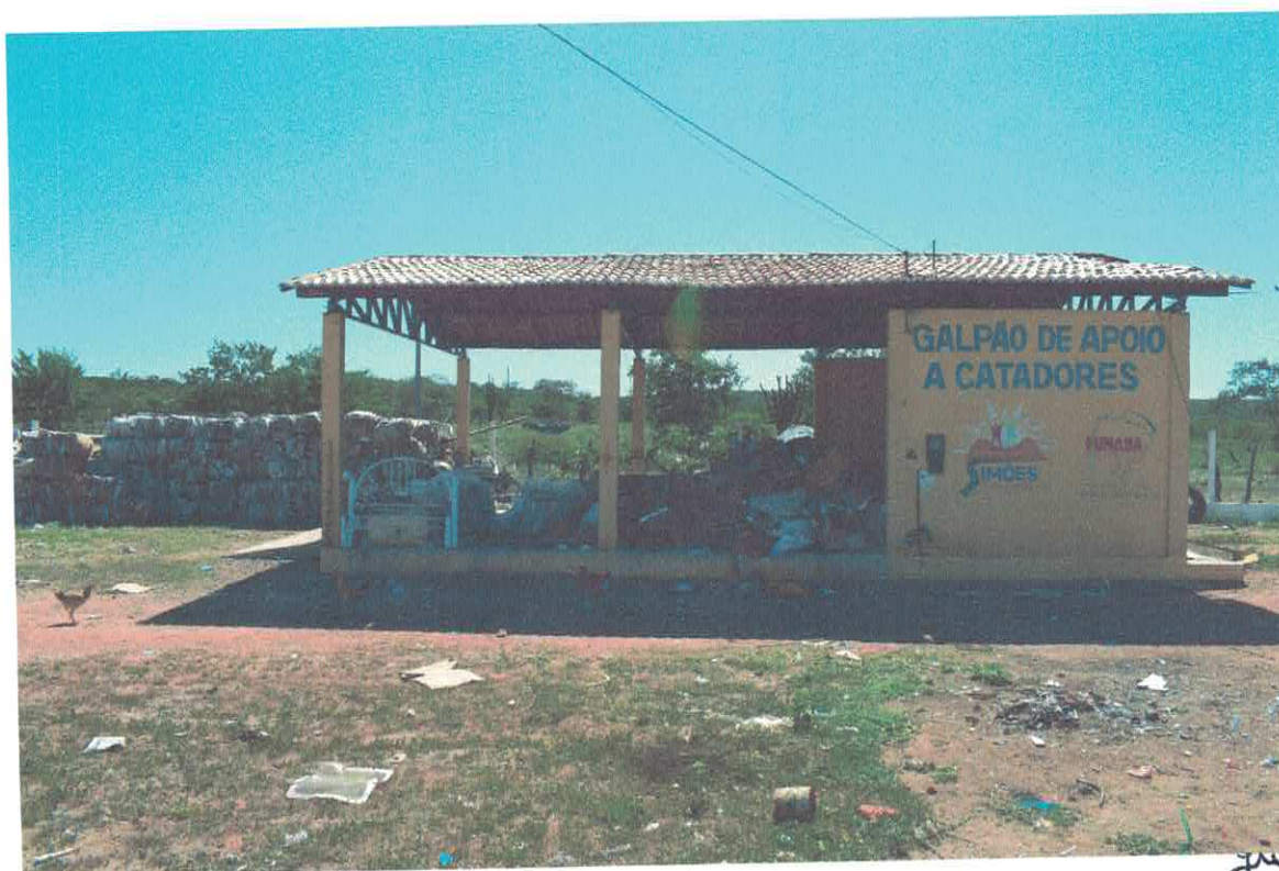
Foto 76 - Galpão de apoio aos catadores de Simões-PI(Foto 1)
