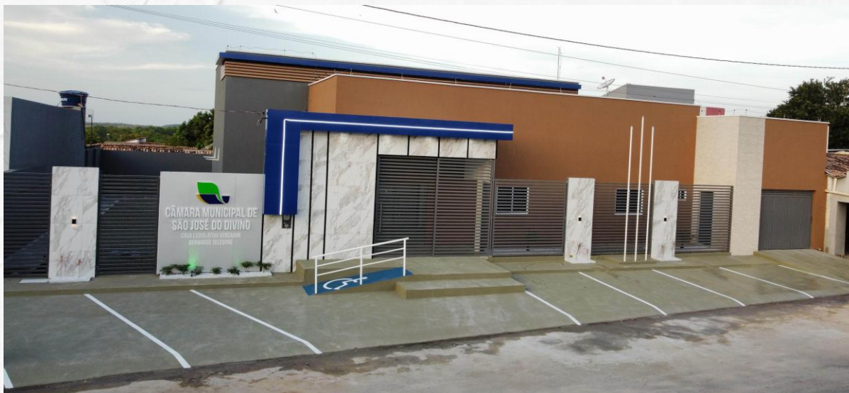
Figura 2 – Sede da Câmara Municipal
