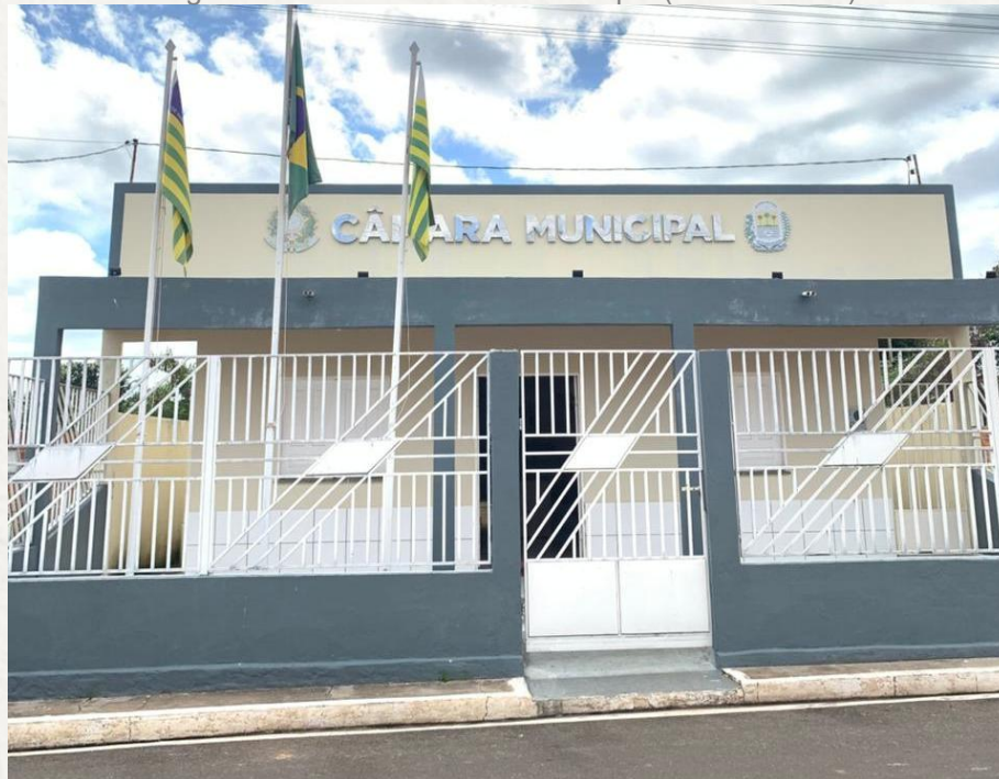
Figura 2 – Sede da Câmara Municipal (visão externa)
