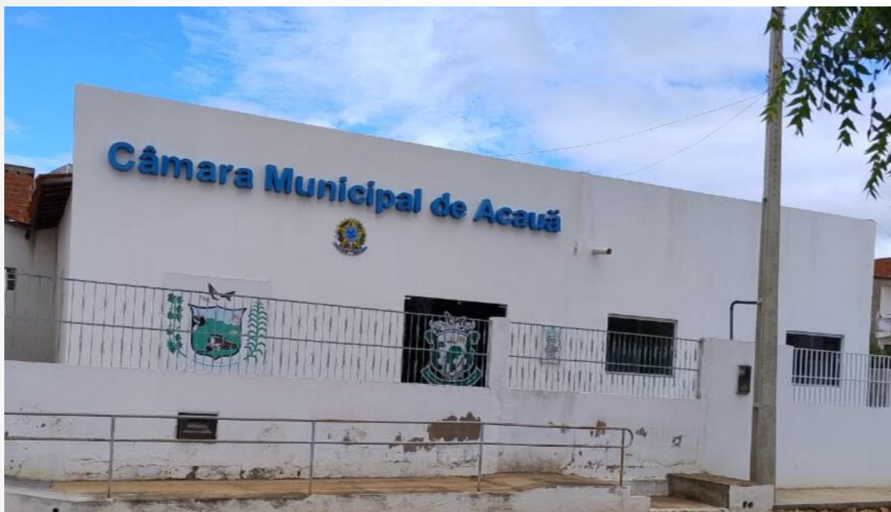
Figura 2 – Visão externa da Câmara Municipal
