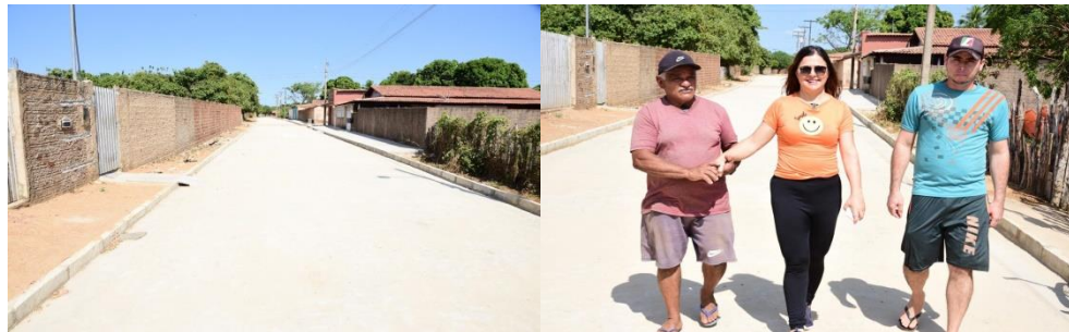
Pavimentação em paralelepípedo na Rua Paulo Ramos.
