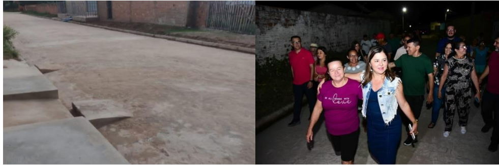
Pavimentação em paralelepípedo na Rua Cícero Simplício.
