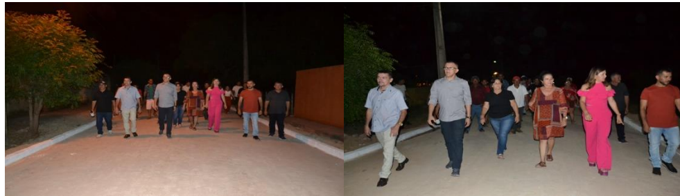
Pavimentação em paralelepípedo zona rural na localidade Mocambinho.
