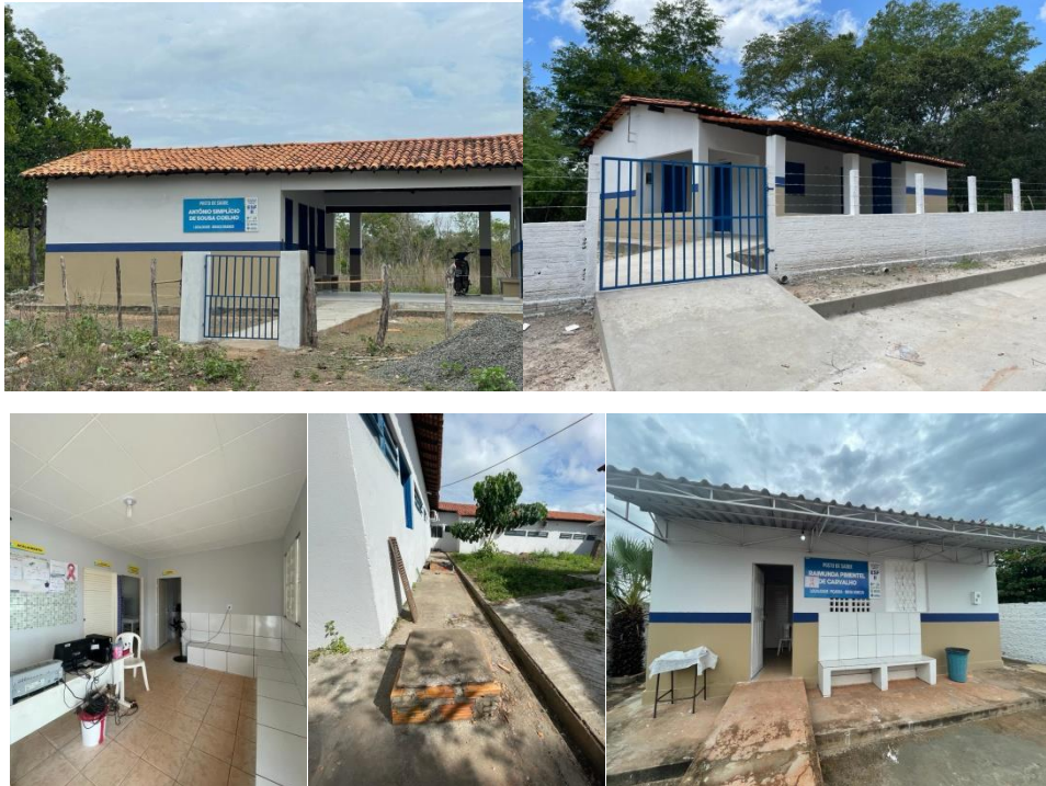
Reforma e reparo nas Unidades de saúde do município de Brasileira-PI.
