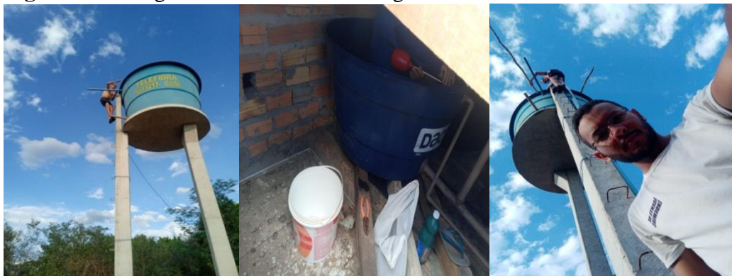
Figura 29. Lavagem do Reservatório de Água
