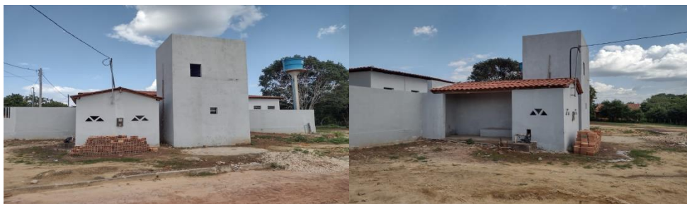
Caixa d'água para abastecimento da comunidade Piçarra.
