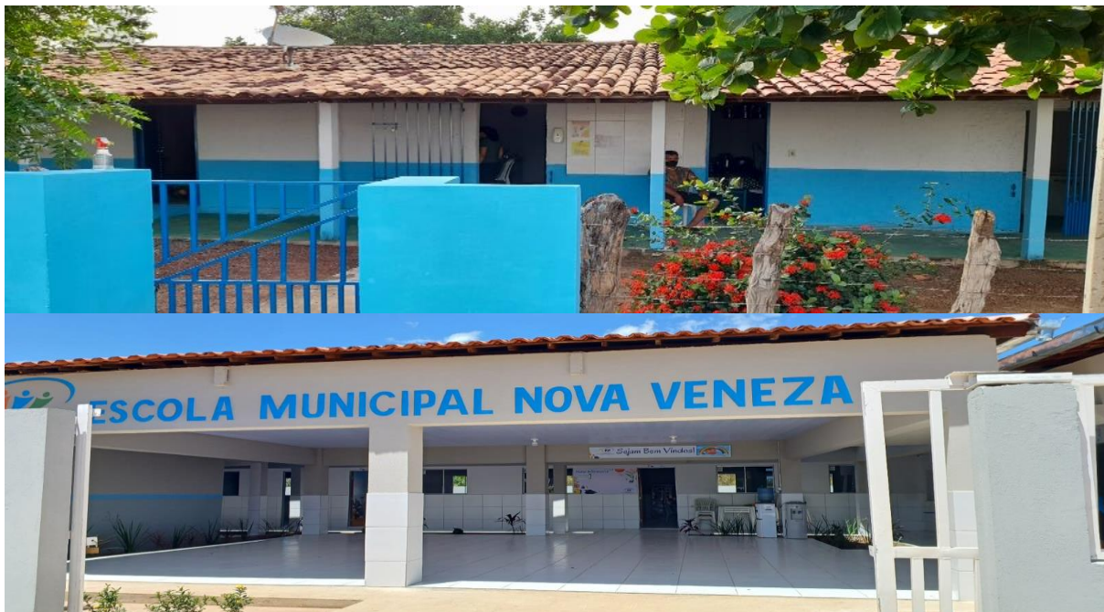
Antes e depois da Reforma da Escola Nova Veneza
