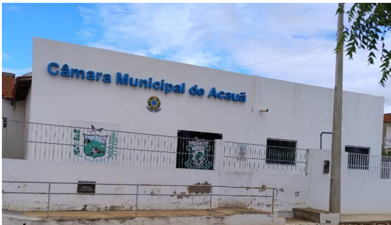
Figura 1 – sede da Câmara Municipal (visão externa)
