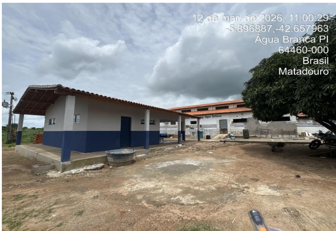
FIGURA 72 OBRA EM ANDAMENTO MATADOURO MUNICIPAL
