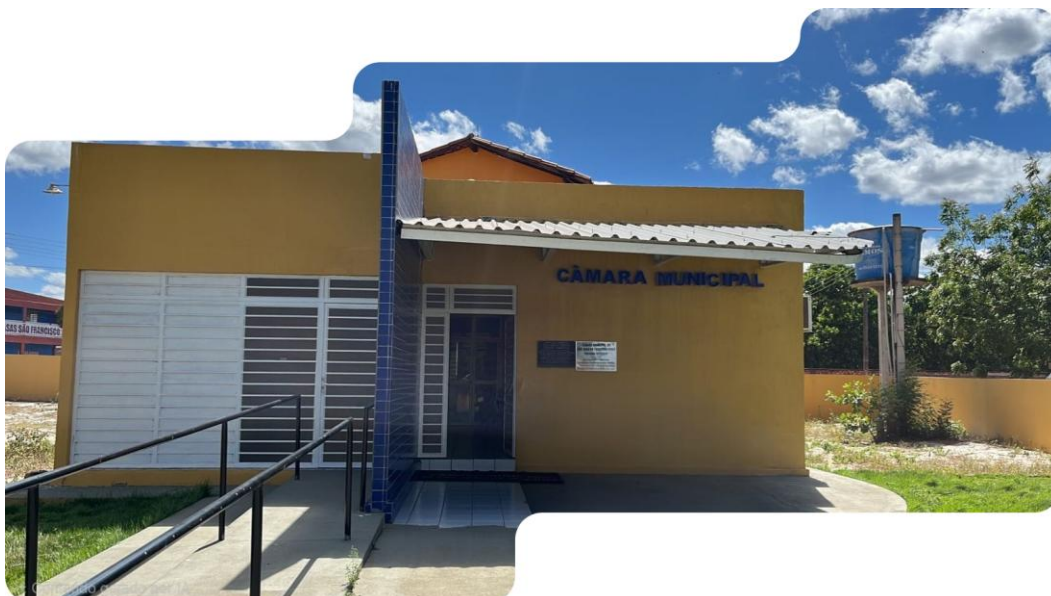
Figura 1 – sede da Câmara Municipal (visão externa)
