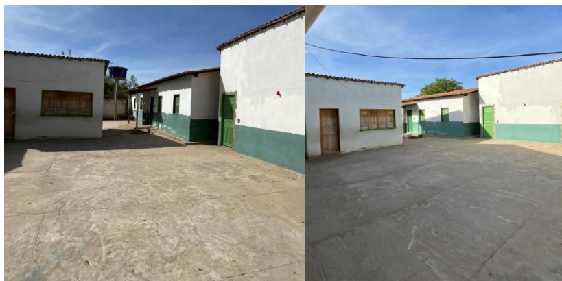
Imagem 77 - Reforma na U E Elesbão da Luz de Brito; Antes
