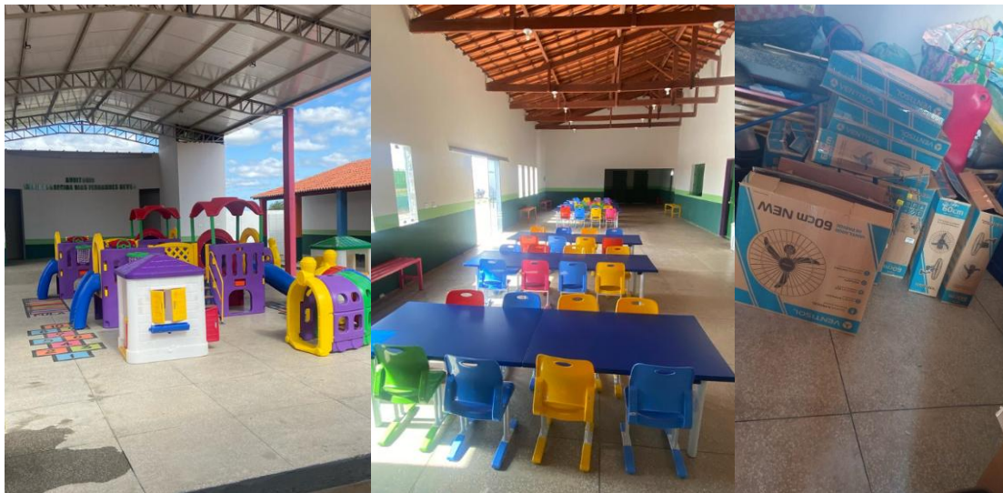
Imagem 79 - Reforma CMEI Engenheiro Raimundo Nonato Campinho Braga
