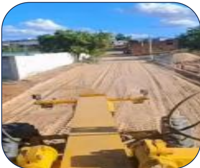
Figura 47: Pavimentação – Rua do Cemitério Municipal
