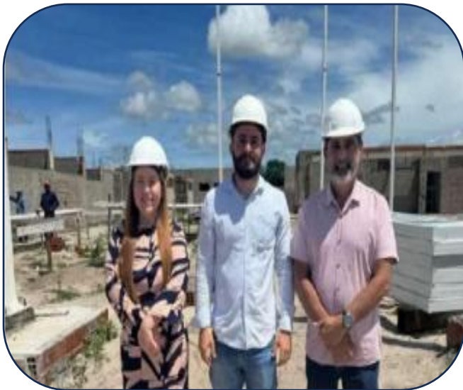
Figura 18: Visita da Secretária de Educação à construção da nova escola no bairro
