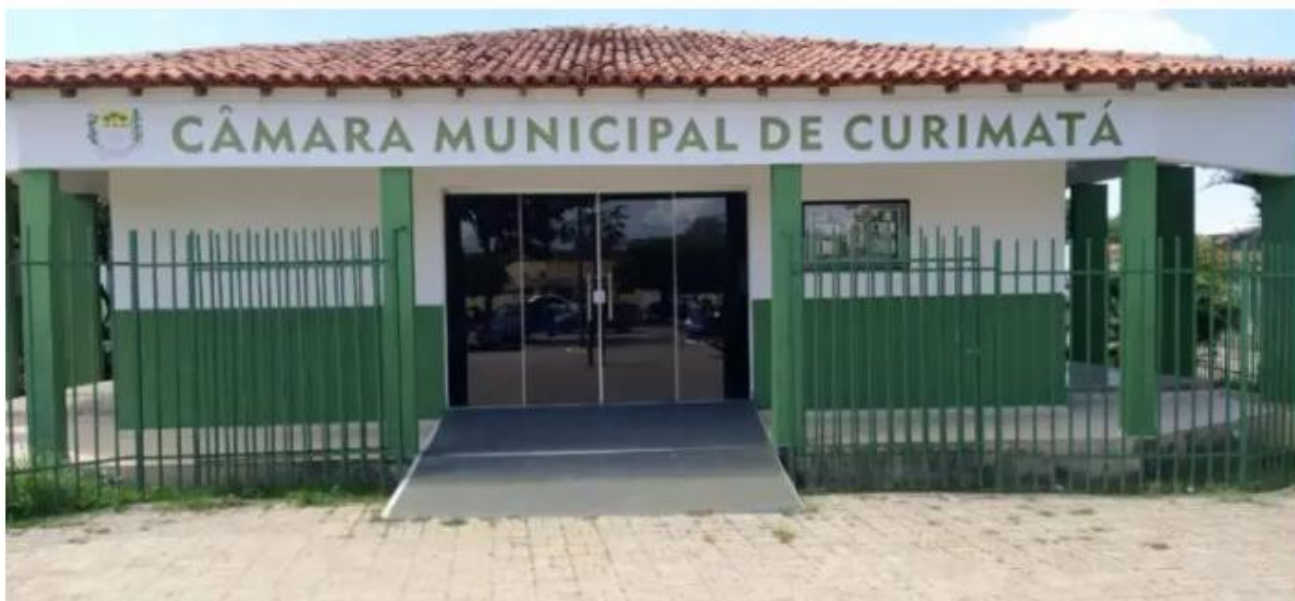
Figura 1 – Sede da Câmara Municipal
