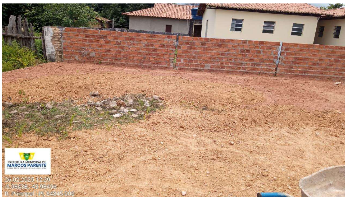
Figura 6: Área de construção da academia popular
