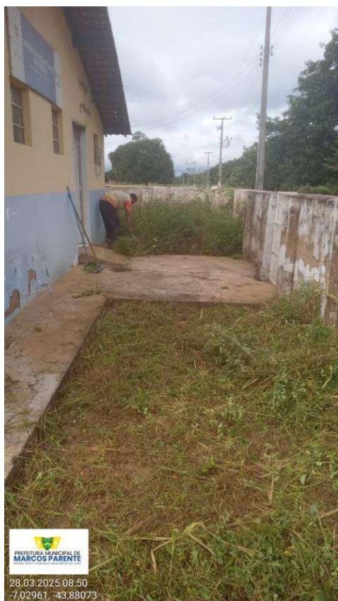
Figura 9: Manutenção unidade básica de saúde
