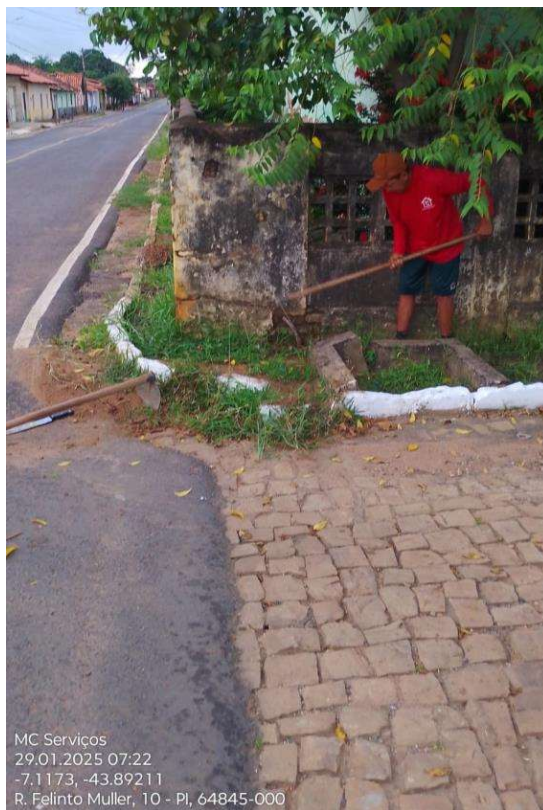
Figura 23: Limpeza de galhos
