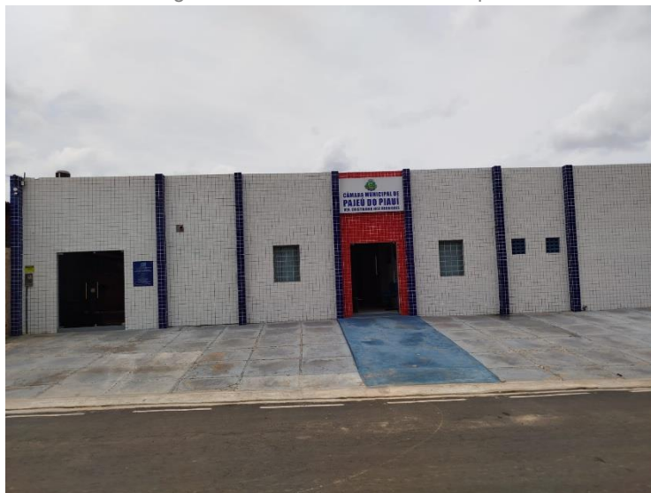
Figura 2 – Sede da Câmara Municipal
