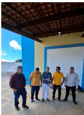
Figura 12. Visita às obras dos Quiosques da Avenida Cândido Mendes
