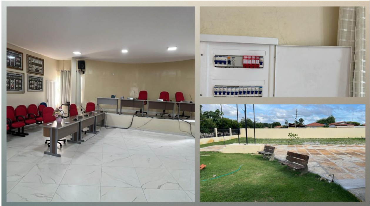
Figura 7 – Melhorias na infraestrutura
