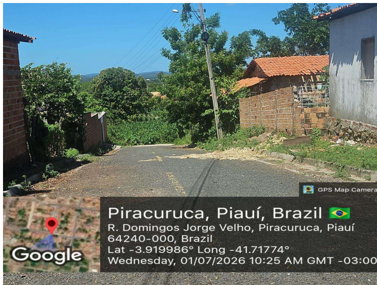
Foto 61 – Rua Domingos Jorge Velho com pavimento em pedras, vegetação avançando sobre o bordo e ausência de sarjetas contínuas. Coordenadas: -3.919986, -41.717740.
