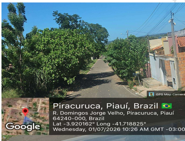
Foto 62 – Rua Domingos Jorge Velho com seção estreita, arborização densa e drenagem superficial pelo próprio pavimento. Coordenadas: -3.920162, -41.718825.
