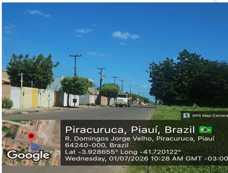
Foto 70 – Rua Domingos Jorge Velho em trecho pavimentado e largo, com escoamento superficial direcionado para as laterais. Coordenadas: -3.928655, -41.720122.
