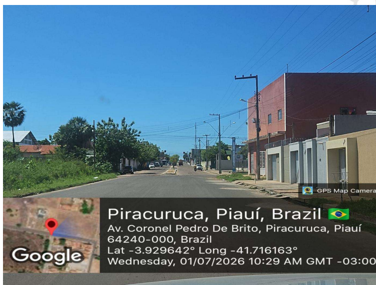
Foto 72 – Avenida Coronel Pedro de Brito com pavimento, ocupação urbana de um lado e lote vegetado do outro, sem captação pluvial visível. Coordenadas: -3.929642, -41.716163.
