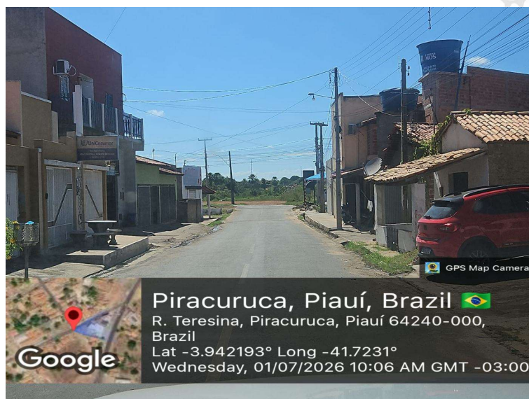
Foto 16 – Trecho estreito da Rua Teresina, com pavimento, ocupação junto ao alinhamento e ausência aparente de bocas de lobo ou galerias de captação. Coordenadas: -3.942193, -41.723100.
