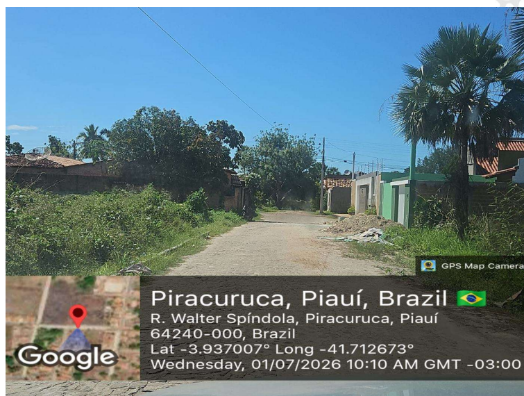
Foto 28 – Rua Walter Spíndola em solo exposto, com trilhas de circulação, vegetação lateral e condução difusa das águas pluviais. Coordenadas: -3.937007, -41.712673.
