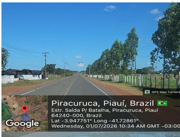
Foto 80 – Estrada de Batalha em trecho asfaltado rural, com arborização linear e drenagem direcionada aos acostamentos. Coordenadas: -3.947751, -41.728610.
