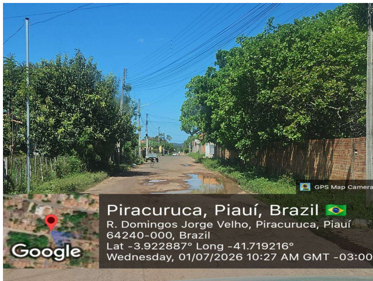
Foto 65 – Rua Domingos Jorge Velho com arborização, bordos sem acabamento e escoamento superficial junto às margens. Coordenadas: -3.922887, -41.719216. Fonte: Acervo técnico da RN Engenharia, levantamento de campo georreferenciado realizado em julho de 2026.
