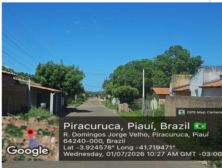
Foto 68 – Rua Domingos Jorge Velho com pavimento em pedras, calçadas descontínuas e condução superficial das águas pluviais. Coordenadas: -3.924578, -41.719471. Fonte: Acervo técnico da RN Engenharia, levantamento de campo georreferenciado realizado em julho de 2026.
