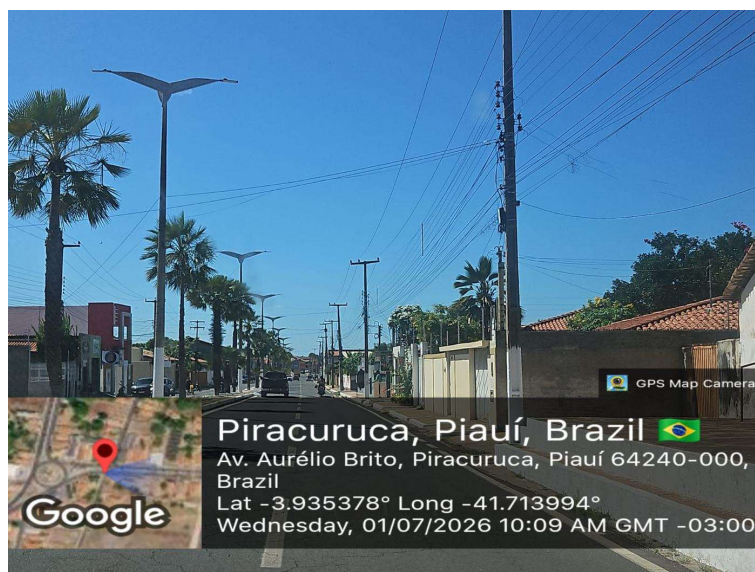
Foto 23 – Avenida Aurélio Brito com pavimento contínuo, iluminação pública e canteiro central, apresentando escoamento pluvial superficial junto ao meio-fio. Coordenadas: -3.935378, -41.713994.
