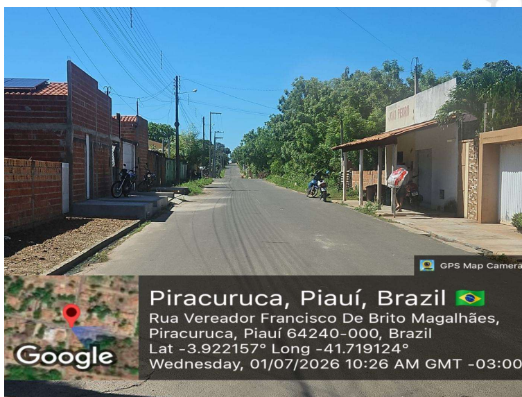
Foto 66 – Rua Vereador Francisco de Brito Magalhães com pavimento contínuo, ocupação comercial e drenagem superficial pelo meio-fio. Coordenadas: -3.922157, -41.719124. Fonte: Acervo técnico da RN Engenharia, levantamento de campo georreferenciado realizado em julho de 2026.
