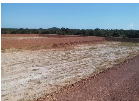
Foto 14: Escavações para implantação das Lagoas de Estabilização.
