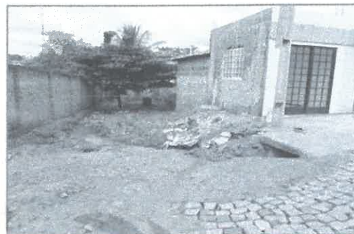
Foto 6.1.11 – Disposição inadequada de RCD em Oeiras
