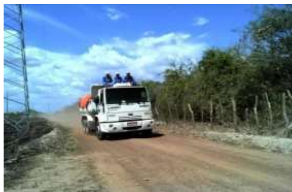
Foto 17: Acesso ao depósito de lixo-"Aterro controlado"
