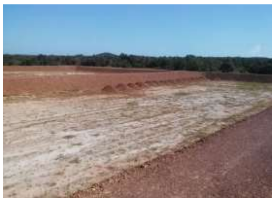
Foto 14: Escavações para implantação das Lagoas de Estabilização.
