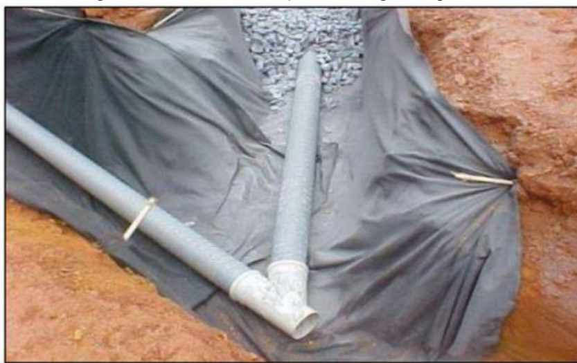
Figura 3- Modelo da instalação da drenagem de percolado
